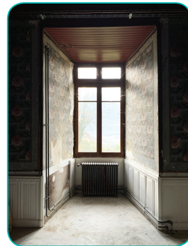
Restauration des soubassements et distribution des radiateurs
