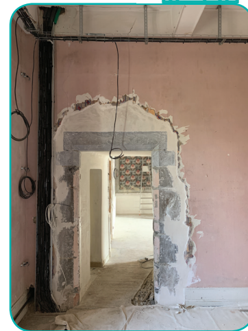
Élargissement de l'ouverture et distribution électrique
