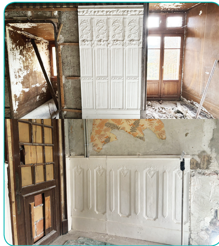
Restitution des soubassements amiantés
