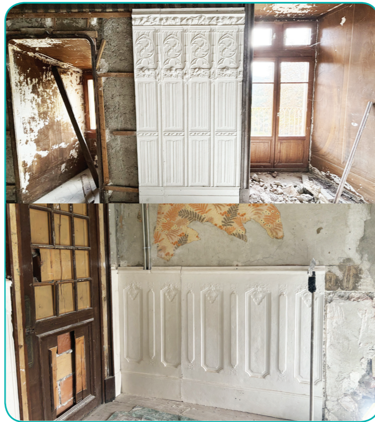
Restitution des soubassements amiantés
