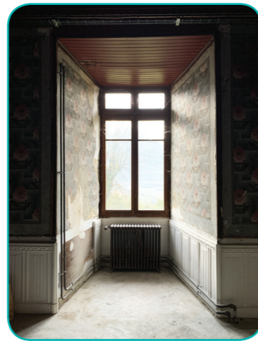
Restauration des soubassements et distribution des radiateurs
