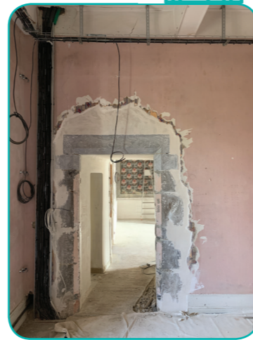
Élargissement de l'ouverture et distribution électrique
